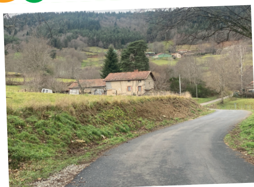
Travaux de voirie à Chazeau
