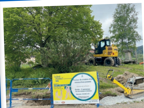
Travaux d'adduction d'eau potable au hameau de la Roche
